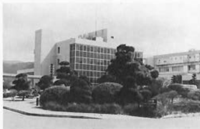
伊豆通信病院（玄関前）
