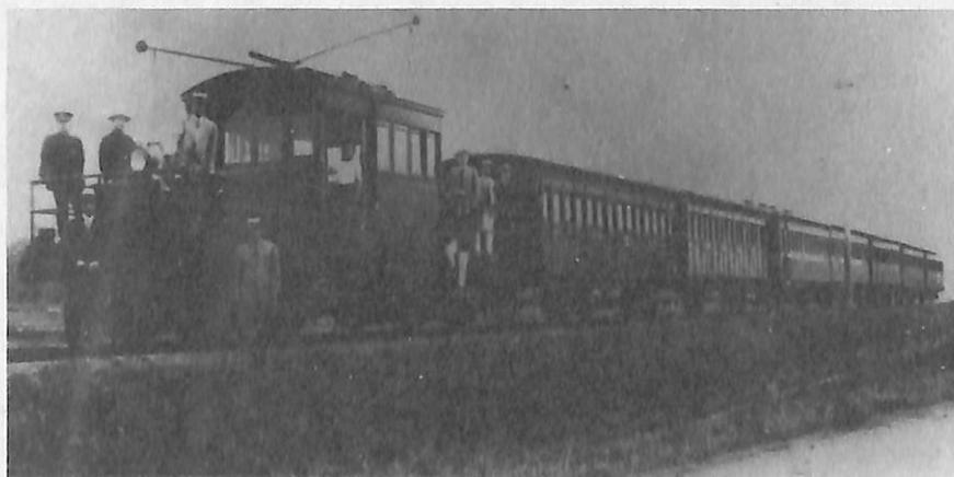
大正7年8月から電気機関車と蒸気機関車が併用された当時の電気機関車
