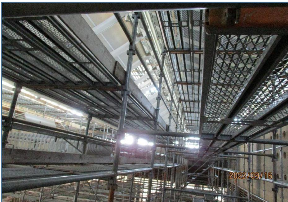
足場が完成して作業が進み、天井吹き抜け部分のライトチューブが取り外されています。
