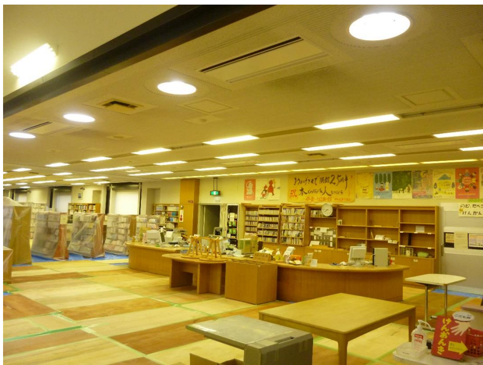
②シートの上から更にベニヤ板が敷かれています。
