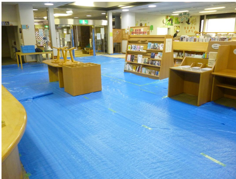
①最初に床全体が青いシートで養生されました。
