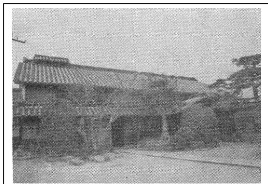
旧 結婚式場主屋外観 「斑鳩町史（昭和54年版）」から
