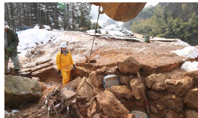
石室内に崩れ落ちている石の撤去作業
